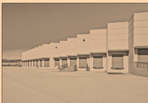
El complejo se inauguró en abril del 2012; su ubicación permite estar cerca de importantes plantas. FOTO: SHUTTERSTOCK
