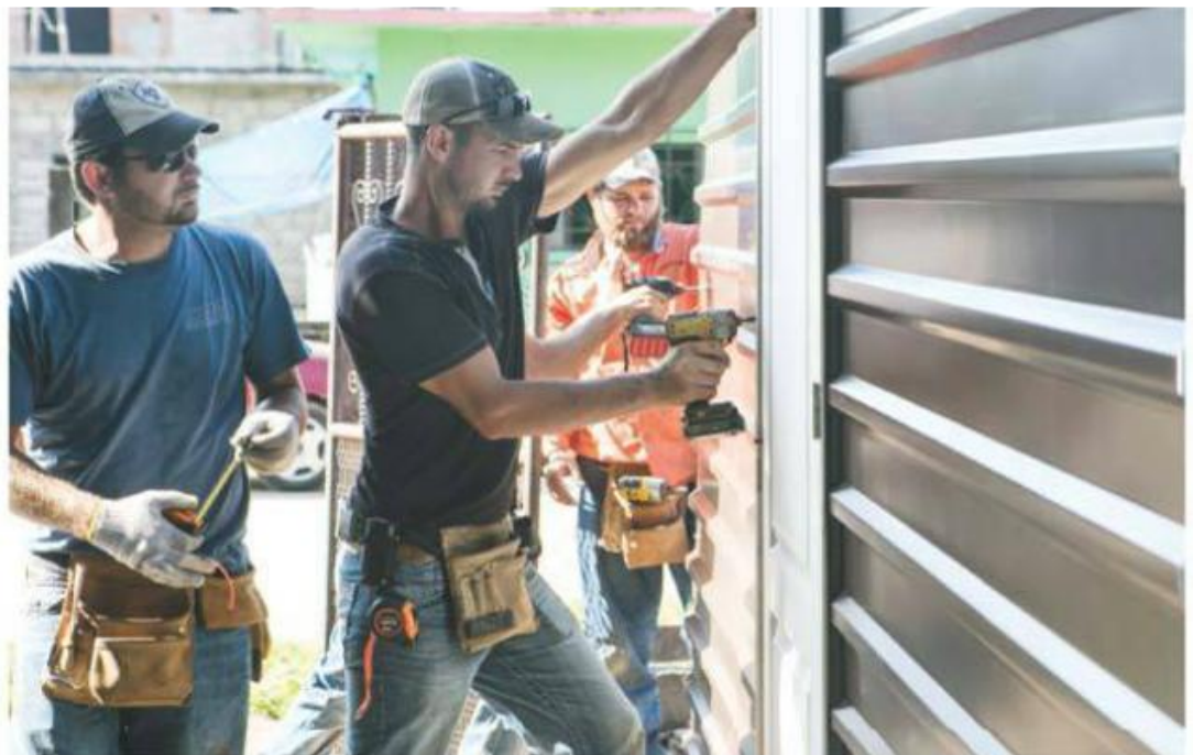
Las casas que construyen los menonitas beneficiarán a personas de la tercera edad y con discapacidad.
