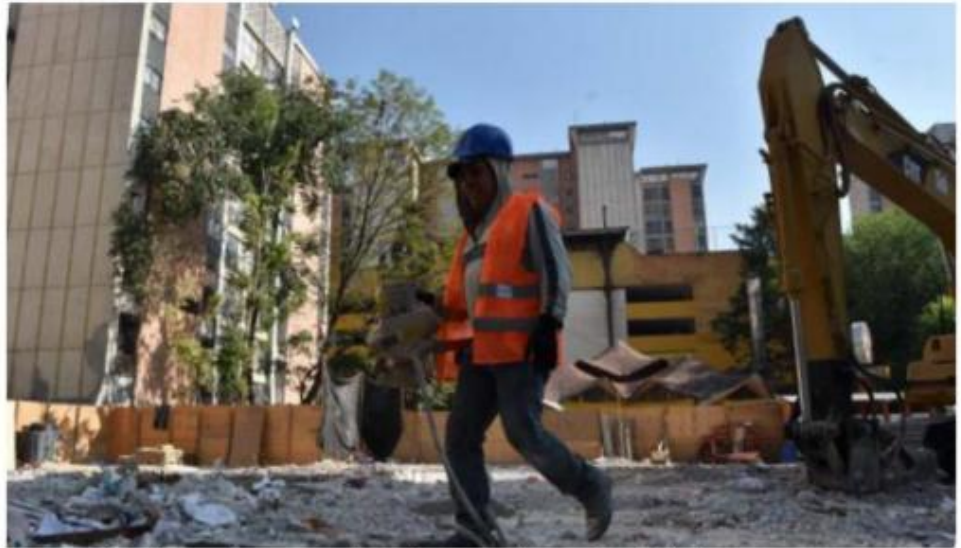
Con maquinaria pesada ya se comienza la excavación para los cimientos/FOTOS: DANIEL GALEANA
