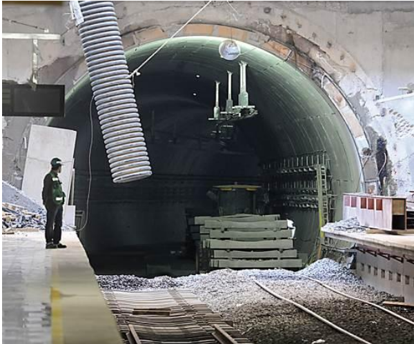
Línea 12 del Metro, construcción del Hospital General de Tláhuac e infraestructura vial. Foto: Archivo / El Sol de México
