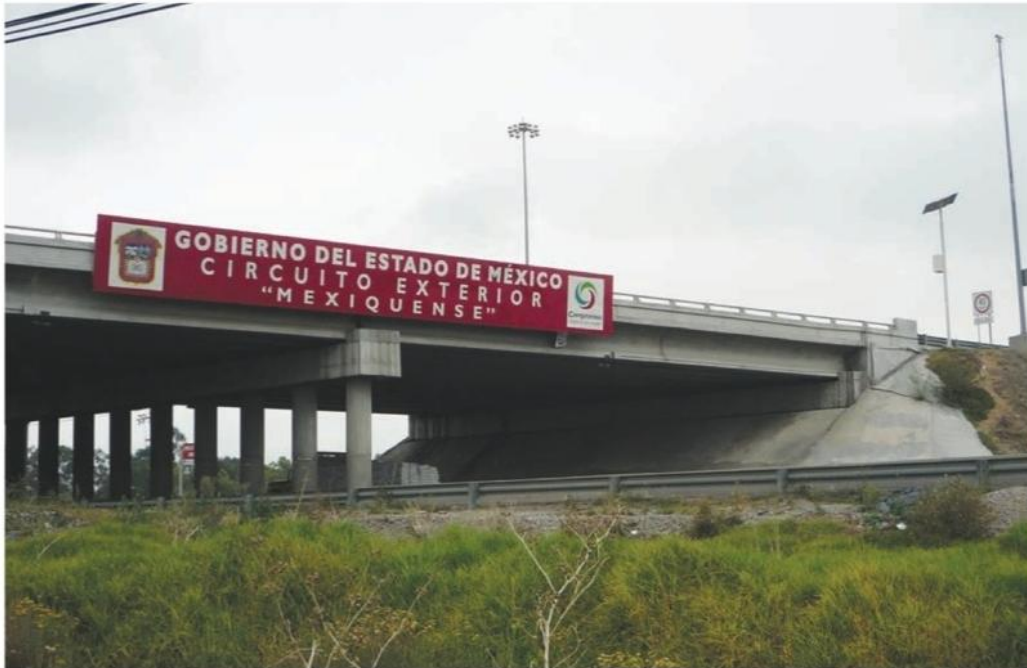
La calificadora otorgó Observación Negativa al Circuito Exterior Mexiquense, operado por Conmex.
