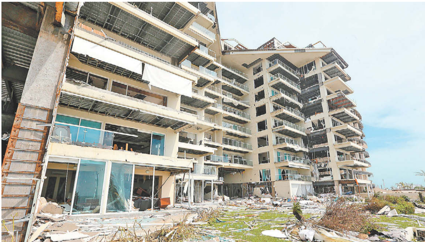
La reedificación de hoteles e inmueble requerirá de nuevas tecnologías de construcción. JORGE CARBALLO
