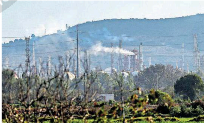
Columnas de humo salen de la refinería de Tula, Hidalgo
