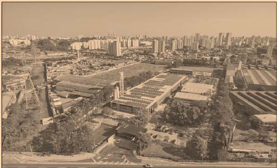
Melicidade, en Brasil, obtiene la mitad de la energía consumida de los 1,800 paneles solares ubicados en el techo del complejo. FOTO: ESPECIAL
