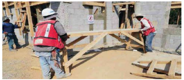
En las nuevas viviendas, la loza será fuerte, pero ligera, con una capa intermedia de unícel y malla electrosoldada, entre dos capas de concreto.
