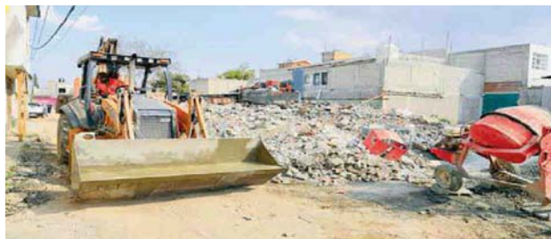
En enero, cuando los predios estaban limpios tras su demolición, grupo Carso envió personal para realizar estudios de suelo y determinar dónde y qué construirían.
