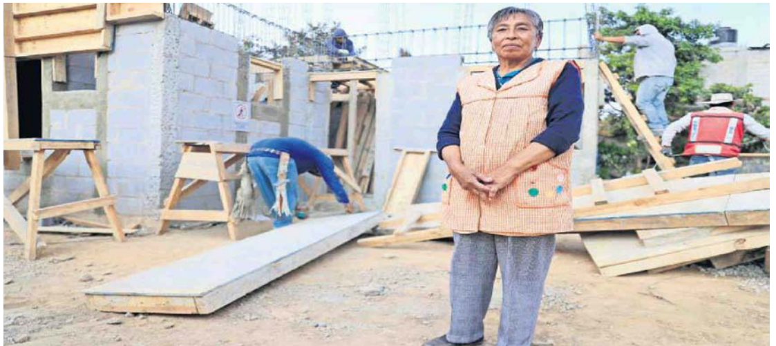
La señora Ana Villarreal vigila la reconstrucción de su casa en el número 39 de la calle Insurgentes. Cuenta que tuvo que pasar fin de año en casa ajena.
